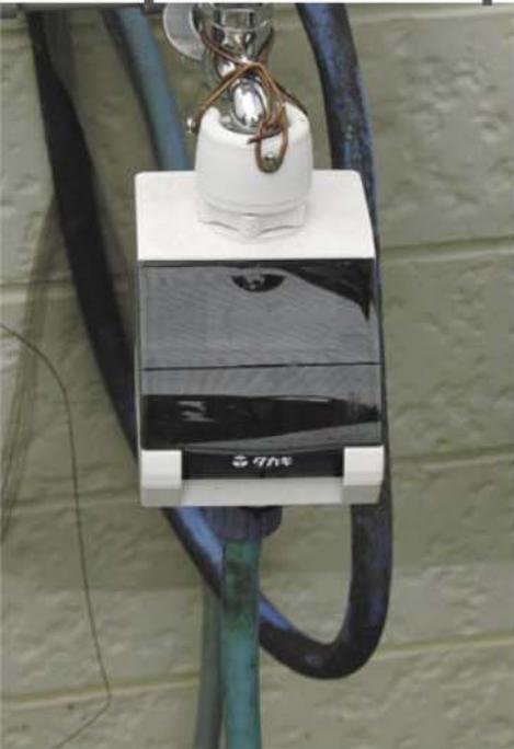
Es un programador de riego automático que funciona con cuatro pilas alcalinas tipo AA. Este programador en concreto es de la marca japonesa "Takagui", pero es similar en prestaciones a los que se encuentran en todos los países del mundo.
