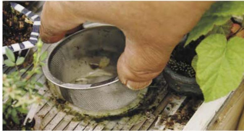
En el fondo del estante más bajo (el estante de la derecha), hay un desagüe con un filtro de los que se usan para hacer el té. Este filtro recoge todos los residuos arrastrados por el agua y evita que el desagüe se llegue a embozar. Este detalle aparentemente nimio, se ha revelado con la práctica muy importante para el mantenimiento de la instalación.
