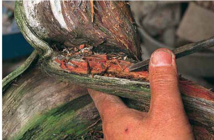
(16) No podemos dejar las partes de madera roja que con el paso del tiempo se han ido pudriendo y debilitando. Por eso las eliminaremos con la ayuda de una gubia.
